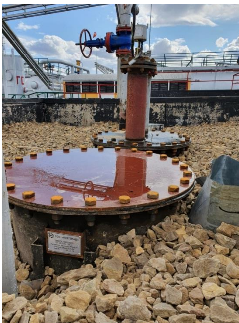
Рисунок 2 – Горловины и замерной люк резервуара стального горизонтального цилиндрического РГС-5
