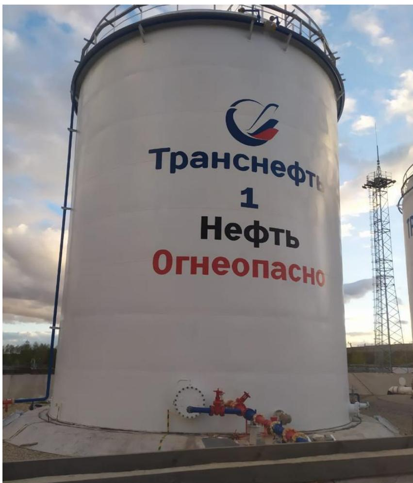
Рисунок 1 – Общий вид резервуара РВС-1000
