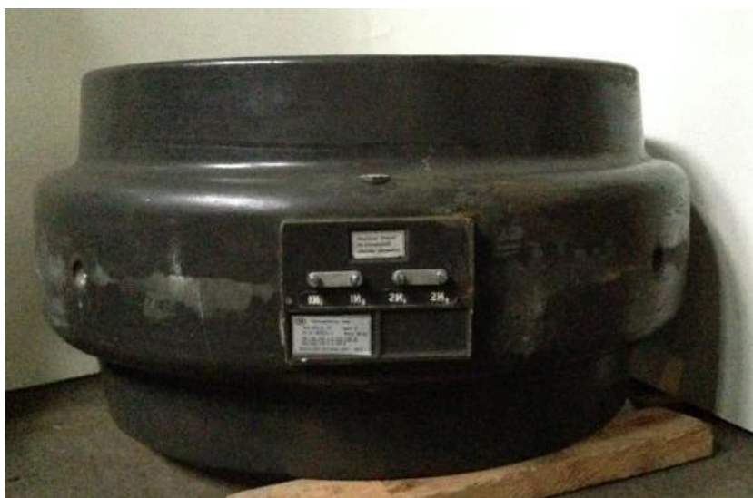
Рисунок 2 – Трансформатор ТШЛ-20 без корпуса (ТШЛ-20Б)
