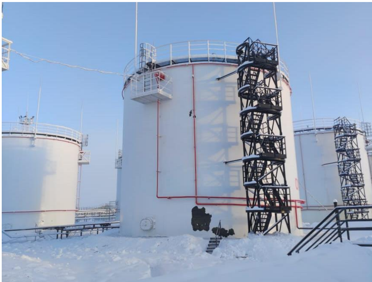
Рисунок 1 – Общий вид резервуаров РВС-2000
