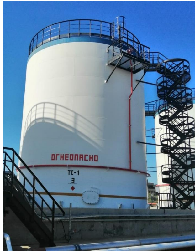
Рисунок 2 – Общий вид резервуаров РВС-1025
