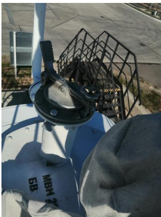
Рисунок 4 – Общий вид резервуаров РВС-1025
