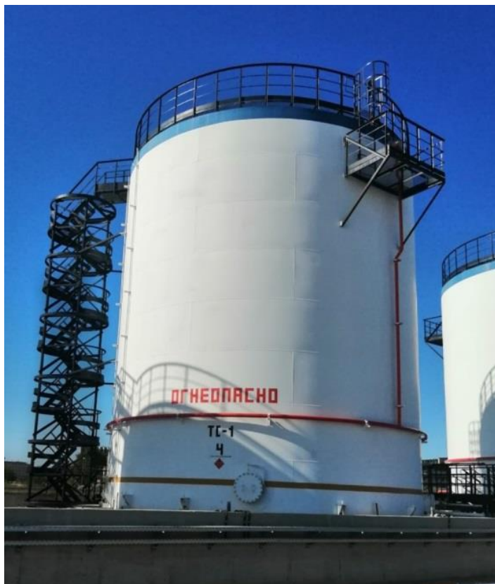
Рисунок 3 – Общий вид резервуаров РВС-1025
