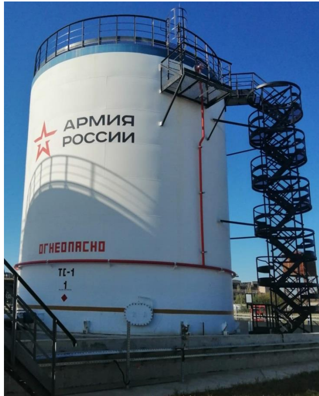
Рисунок 1 – Общий вид резервуаров РВС-1025
