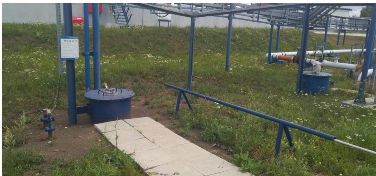
Рисунок 2 – Общий вид резервуара РГС-50
