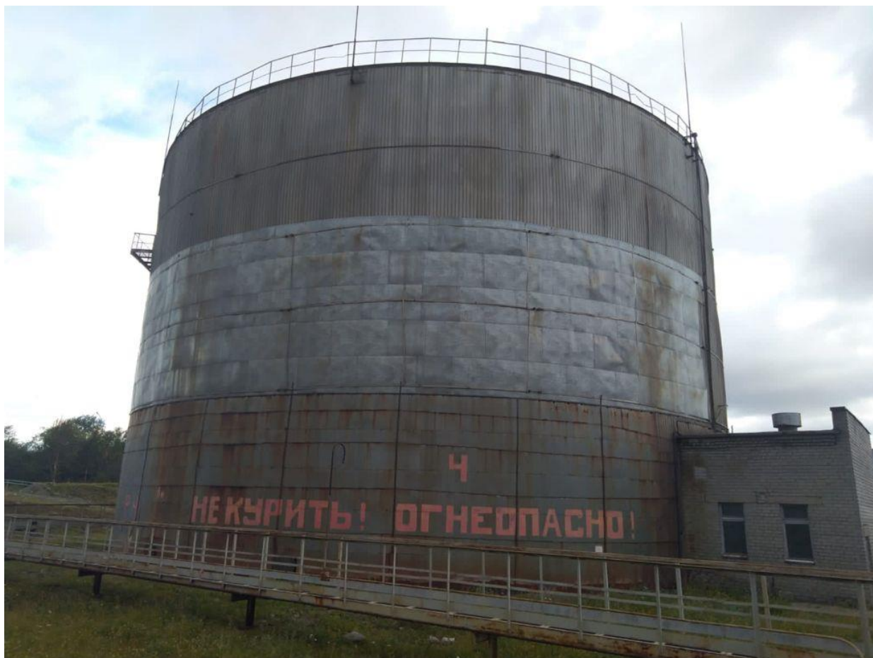
Рисунок 1 – Общий вид резервуара РВС-10000
