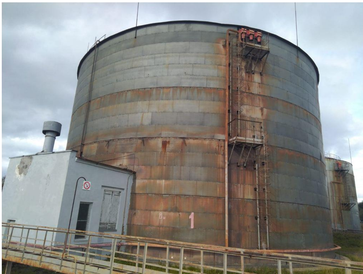
Рисунок 1 – Общий вид резервуара РВС-10000
