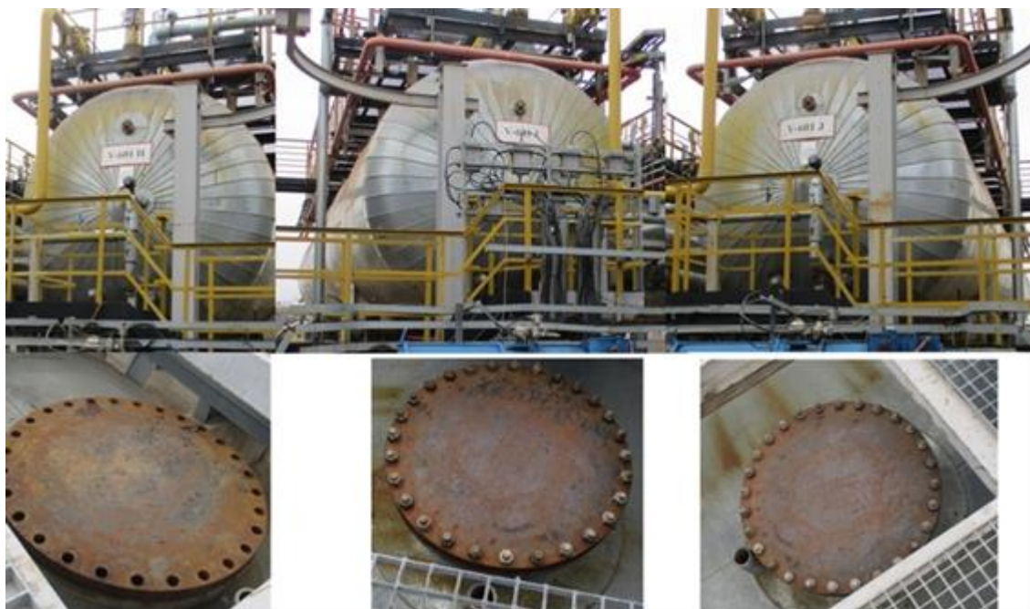
Рисунок 3 – Общий вид резервуаров стальных горизонтальных цилиндрических РГС-200 с заводскими номерами V-601 H, V-601 I, V-601 J
