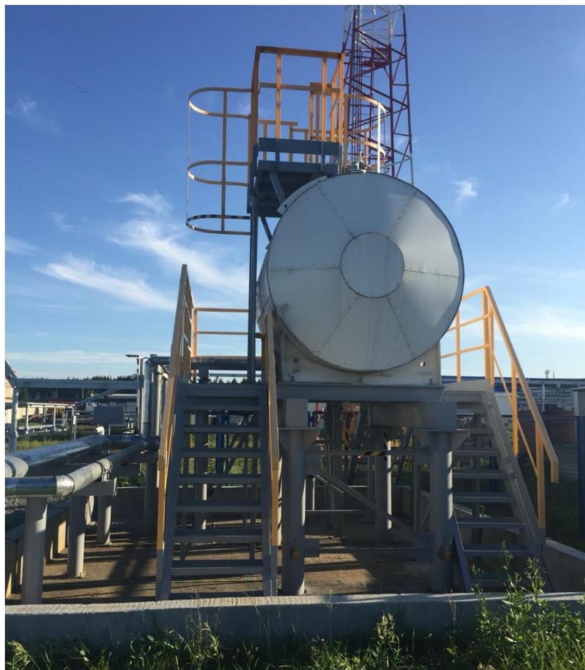
Рисунок 2 – Общий вид резервуара PGC-5
