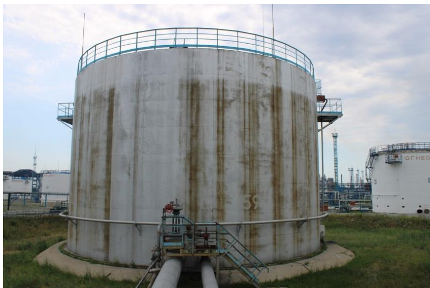
Рисунок 1 – Общий вид резервуаров
