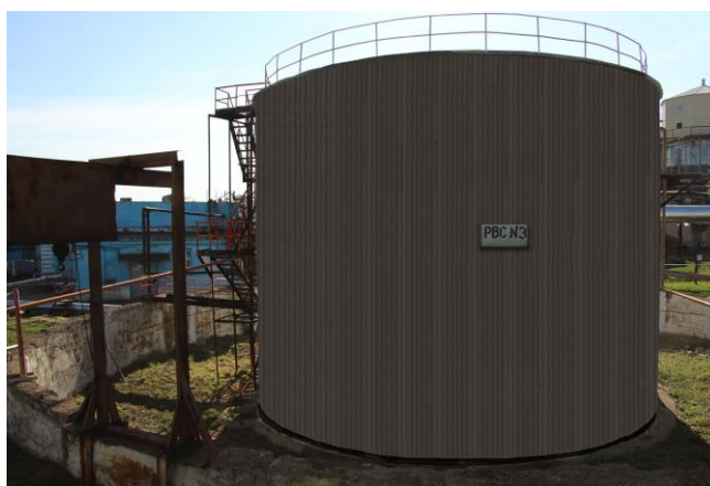
Рисунок 1 – Общий вид резервуара стального вертикального цилиндрического РВС-1000
