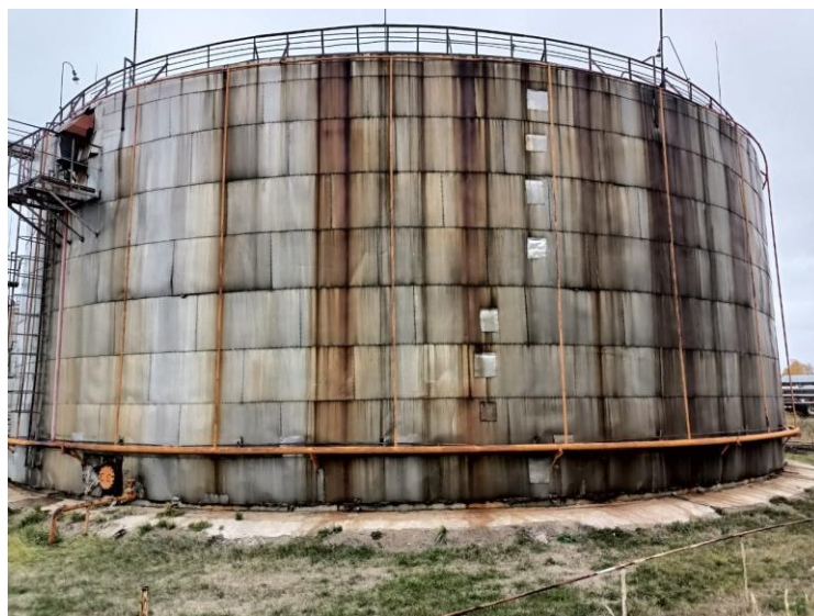
Рисунок 1 – Общий вид резервуара стального вертикального цилиндрического РВС-10000
