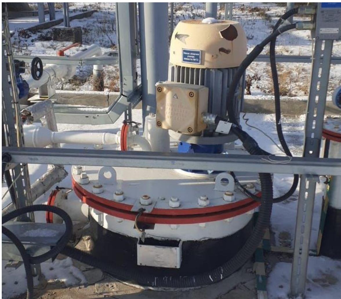
Рисунок 2 – Общий вид резервуара РГС-16
