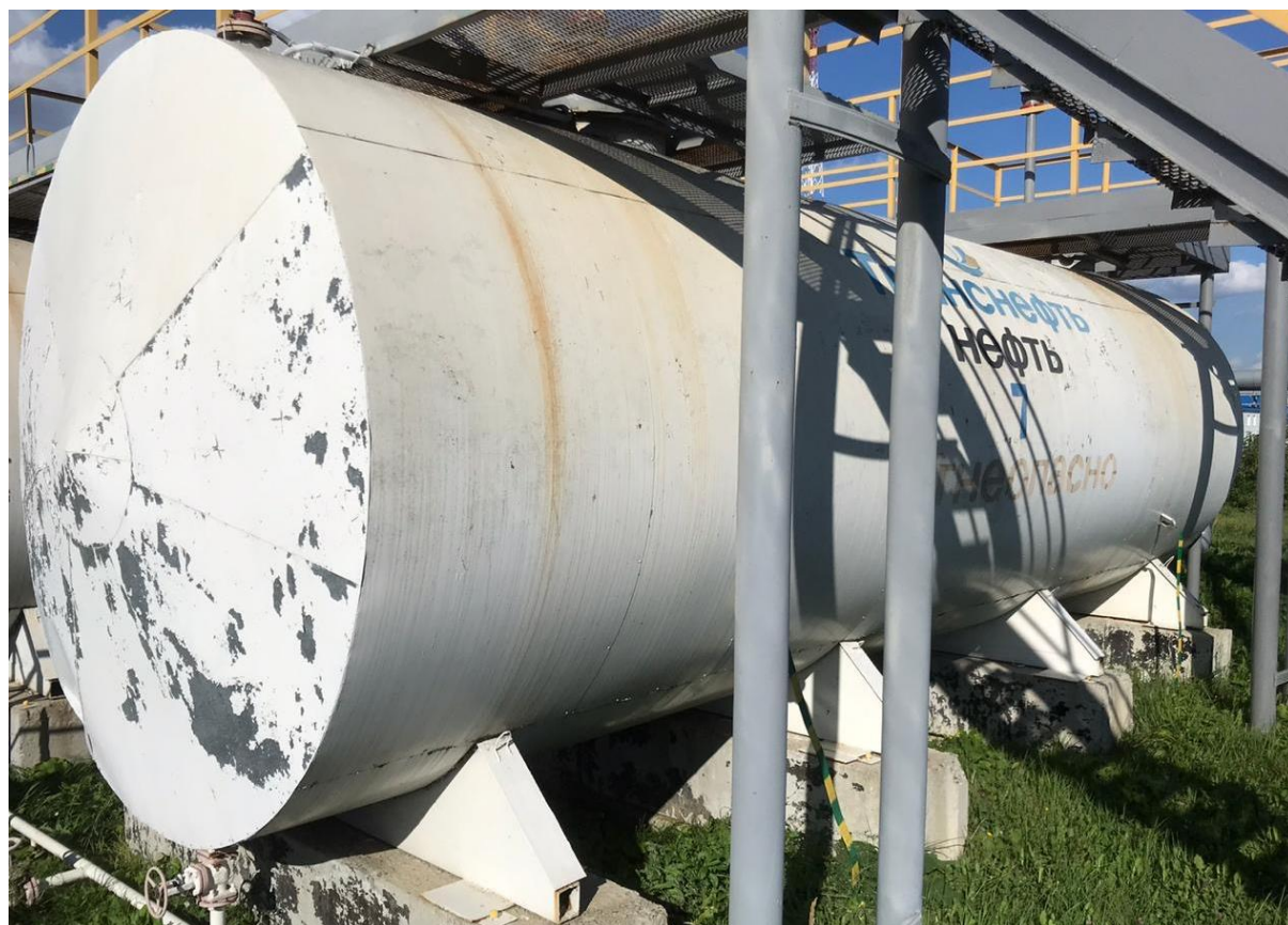
Рисунок 2 – Общий вид резервуара РГС-60 с заводским номером 23
