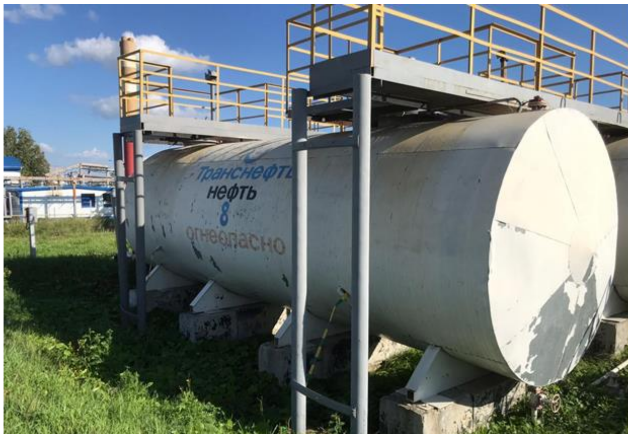
Рисунок 3 – Общий вид резервуара РГС-60 с заводским номером 24 Пломбирование резервуаров РГС-60 не предусмотрено.
