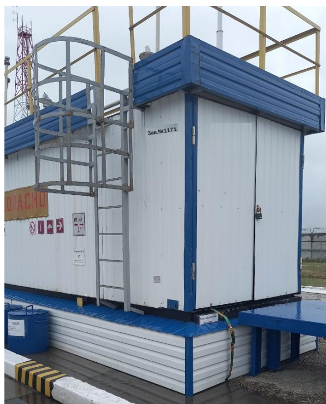
Рисунок 2 – Общий вид резервуара РГС-20 с заводским номером 1171
