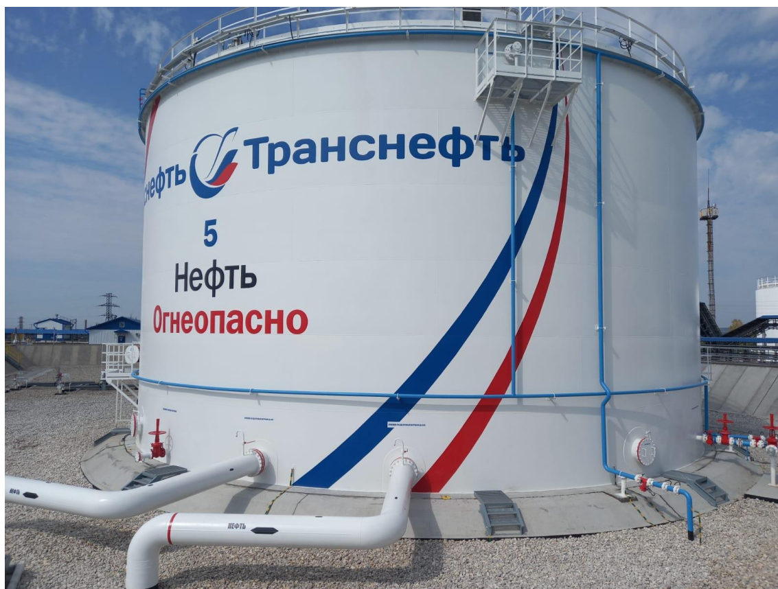
Рисунок 1 – Общий вид резервуара РВСП-5000
