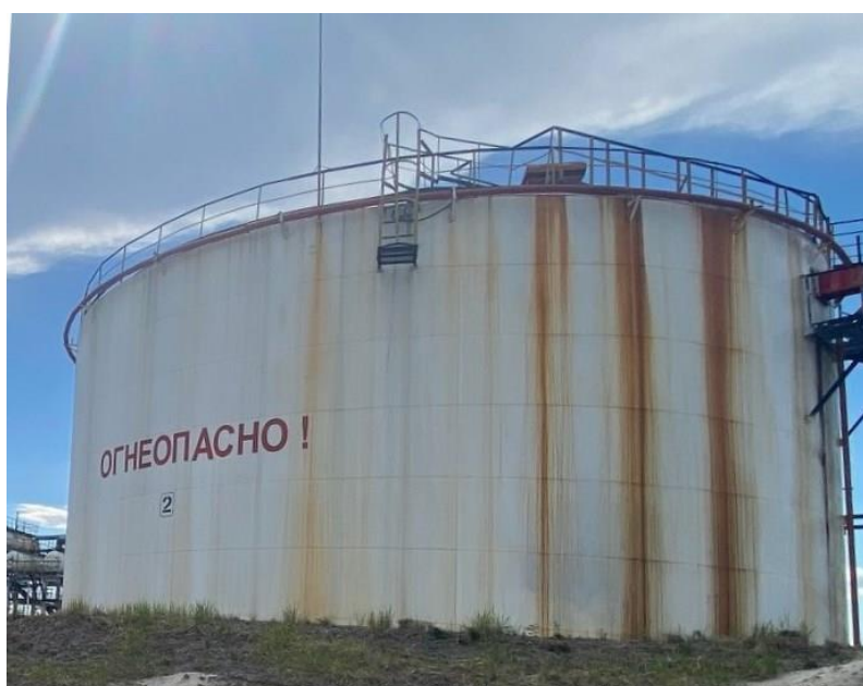
Рисунок 1 – Общий вид резервуара
