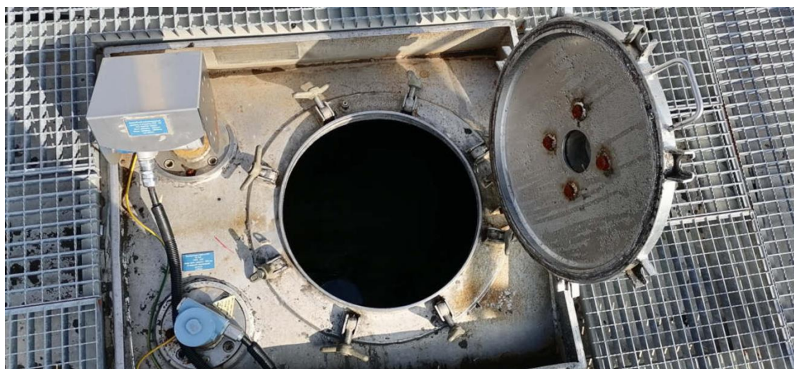
Рисунок 2 – Общий вид резервуара РГС-25
