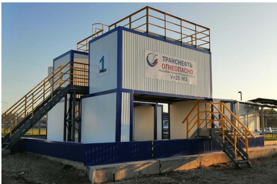
Рисунок 1 – Общий вид резервуара РГС-25
