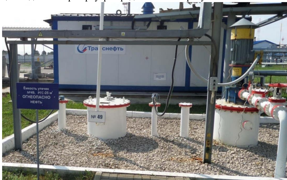
Рисунок 1 – Общий вид резервуара РГС-25
