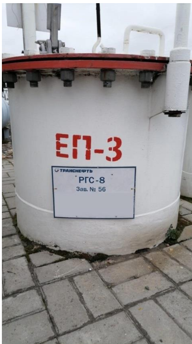
Рисунок 1 – Общий вид резервуара РГС-8
