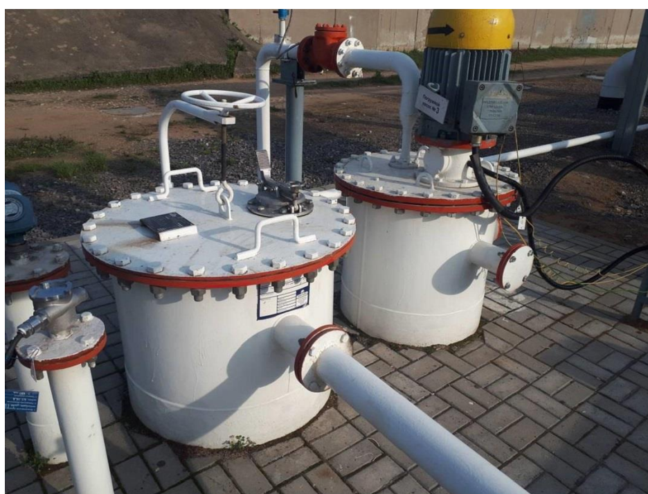
Рисунок 2 – Общий вид резервуара РГС-8
