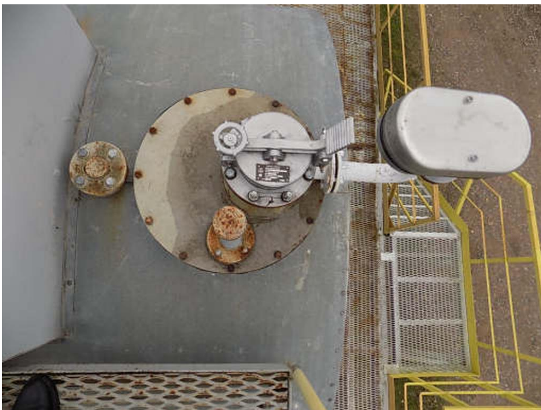
Рисунок 4 – Общий вид резервуаров РГС-40
