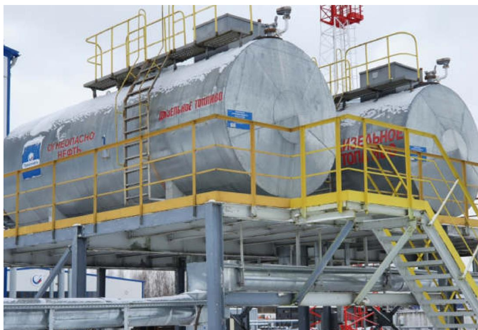
Рисунок 1 – Общий вид резервуаров РГС-40
