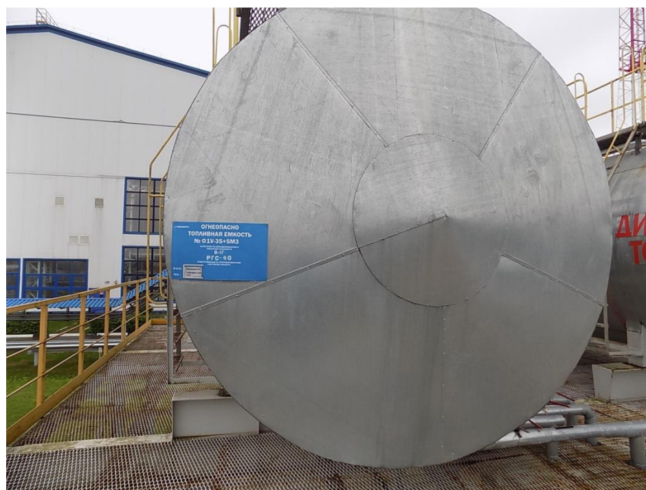
Рисунок 2 – Общий вид резервуара РГС-40 зав.№ 01
