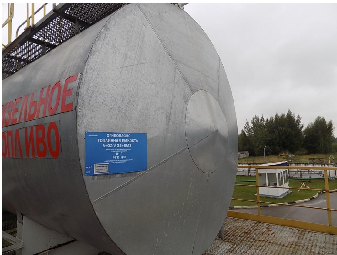
Рисунок 3 – Общий вид резервуара РГС-40 зав.№ 02
