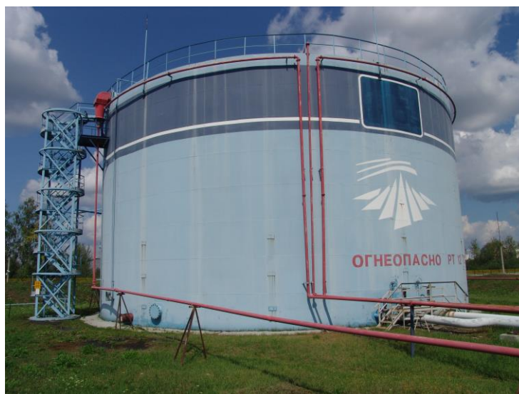
Рисунок 1 – Общий вид резервуаров
