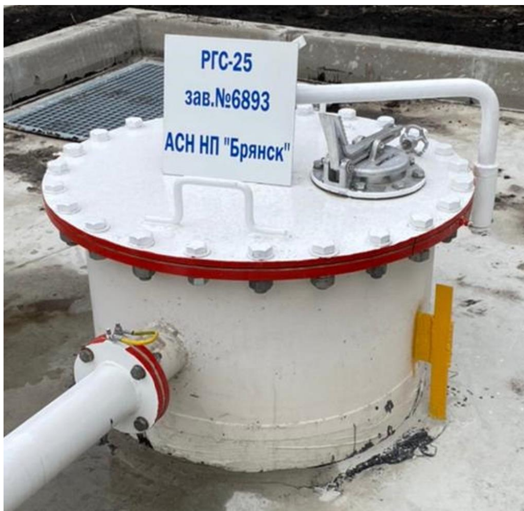
Рисунок 1 – Общий вид резервуара РГС-25
