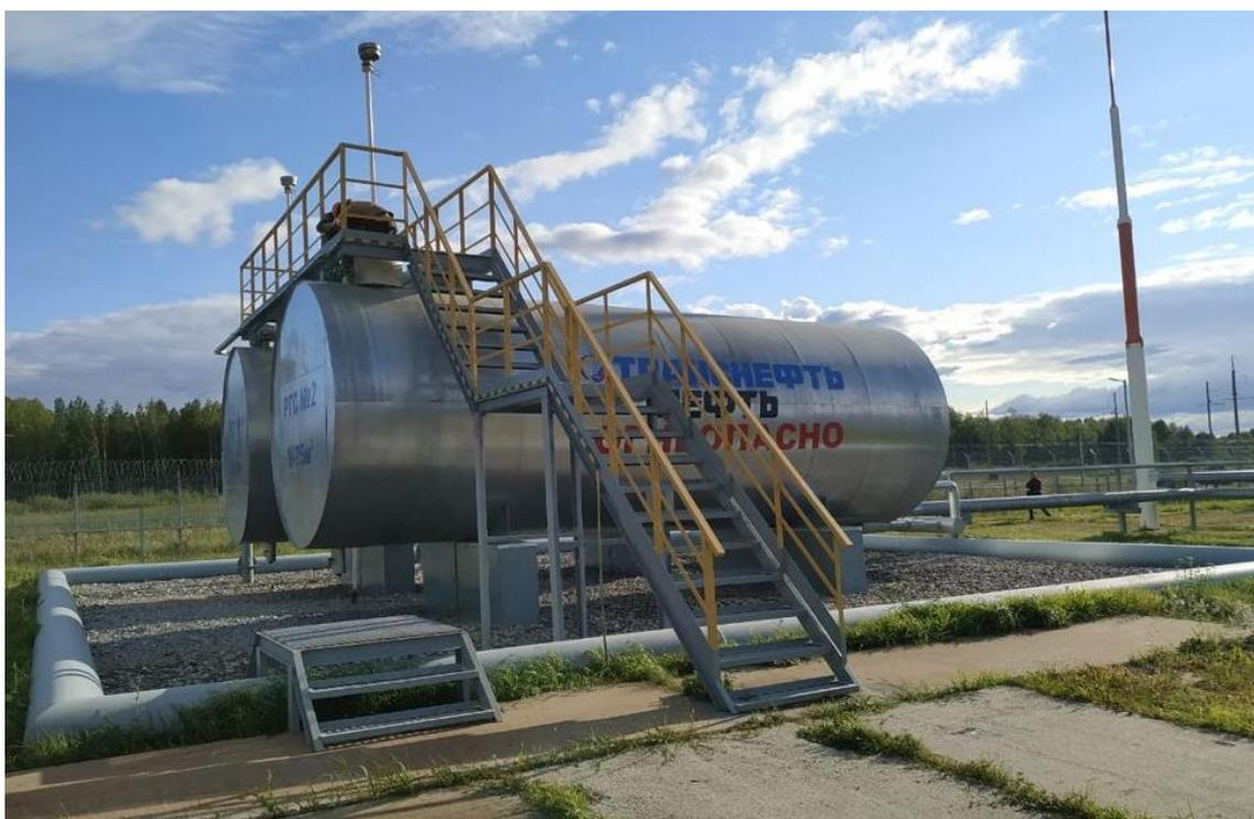
Рисунок 2 – Общий вид резервуаров РГС-75
