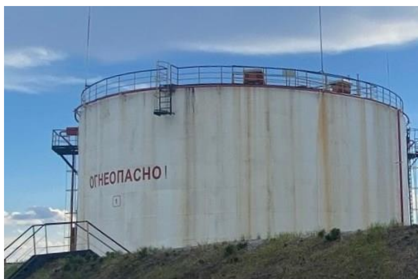
Рисунок 1 – Общий вид резервуара
