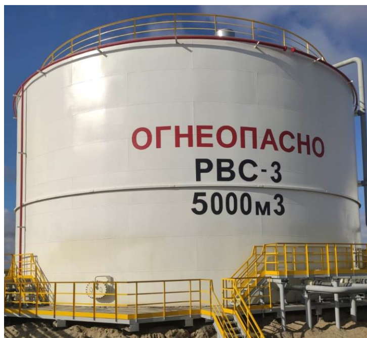
Рисунок 1 – Общий вид резервуаров РВС-5000
