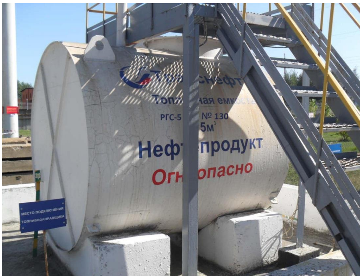
Рисунок 3 – Общий вид резервуара РГС-5 зав.№ 130
