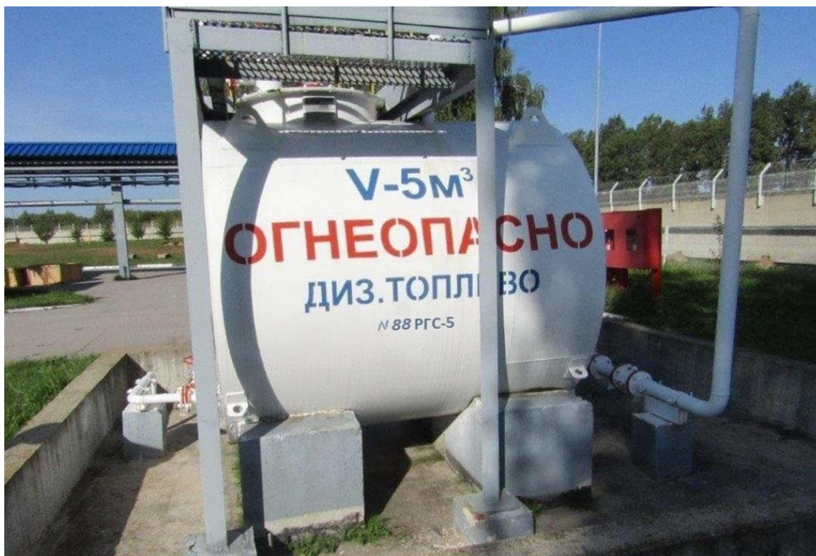
Рисунок 2 – Общий вид резервуара РГС-5 зав.№ 88
