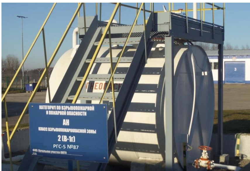
Рисунок 1 – Общий вид резервуара РГС-5 зав. № 87
