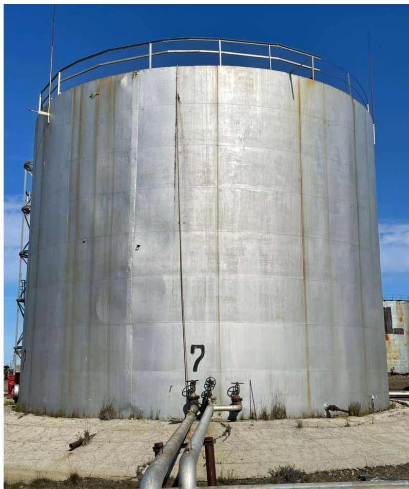
Рисунок 1 – Общий вид резервуара РВС-2000 с заводским номером 7
