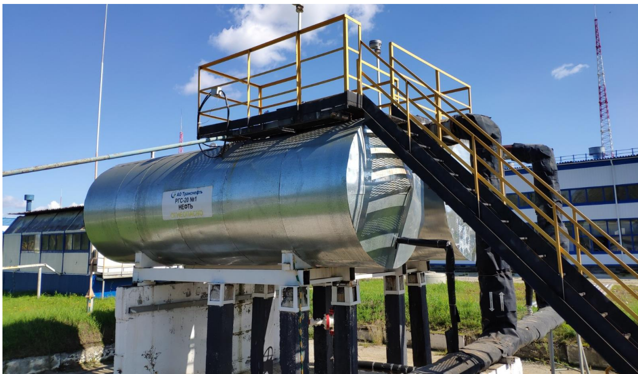
Рисунок 1 – Общий вид резервуара РГС-20 зав.№1
