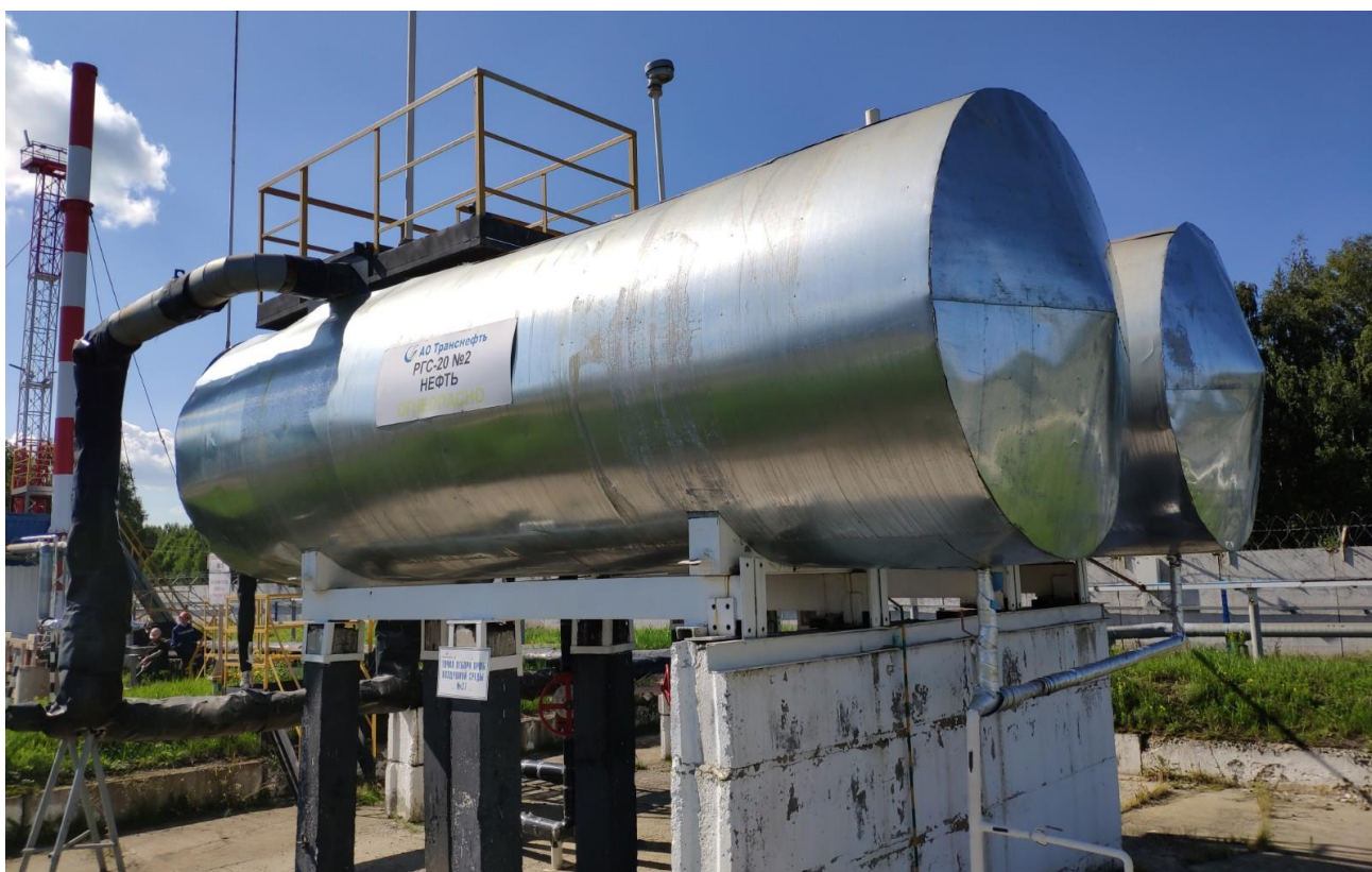
Рисунок 2 – Общий вид резервуара РГС-20 зав.№2
