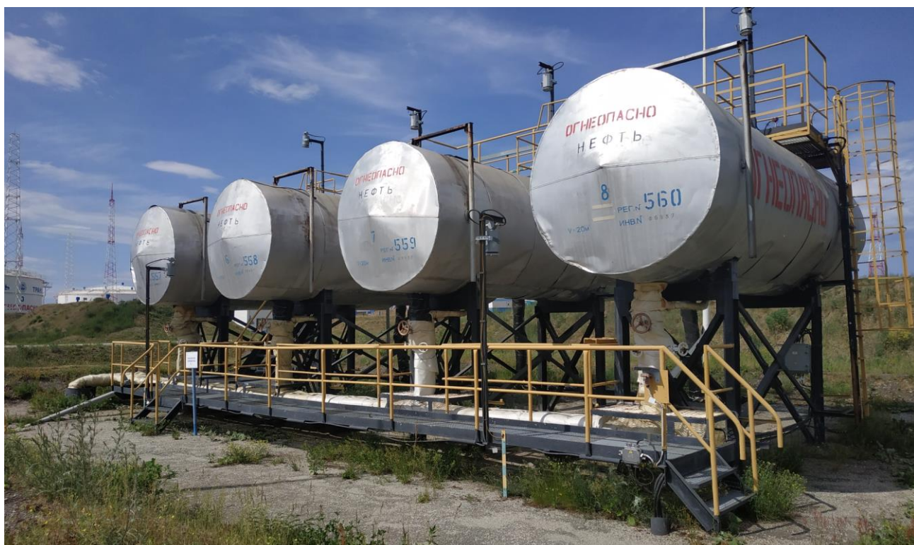
Рисунок 3 – Общий вид резервуаров РГС-20 зав.№№5, 6, 7, 8
