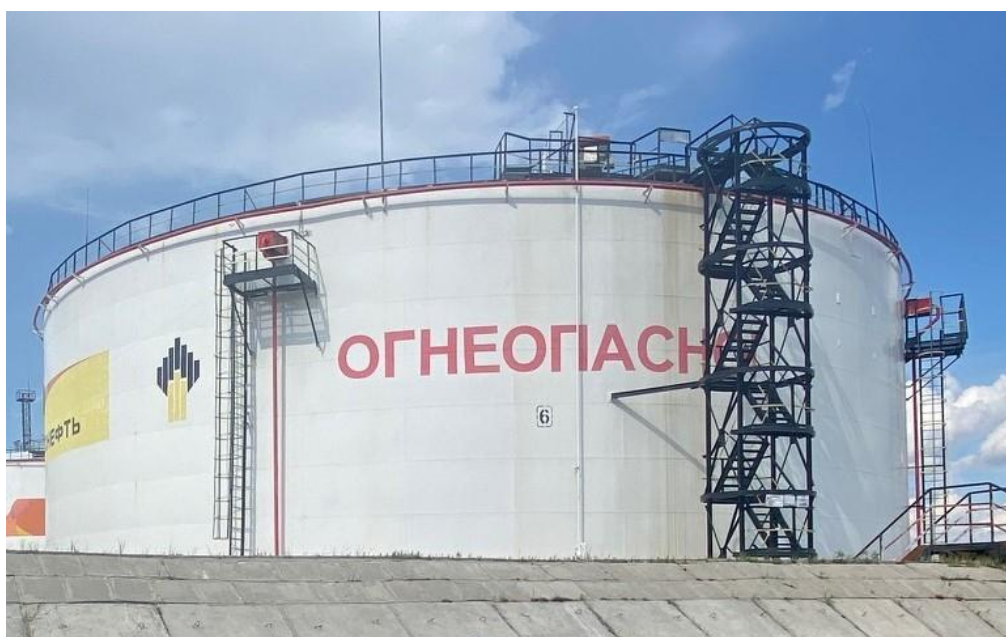
Рисунок 1 – Общий вид резервуаров РВС-10000
