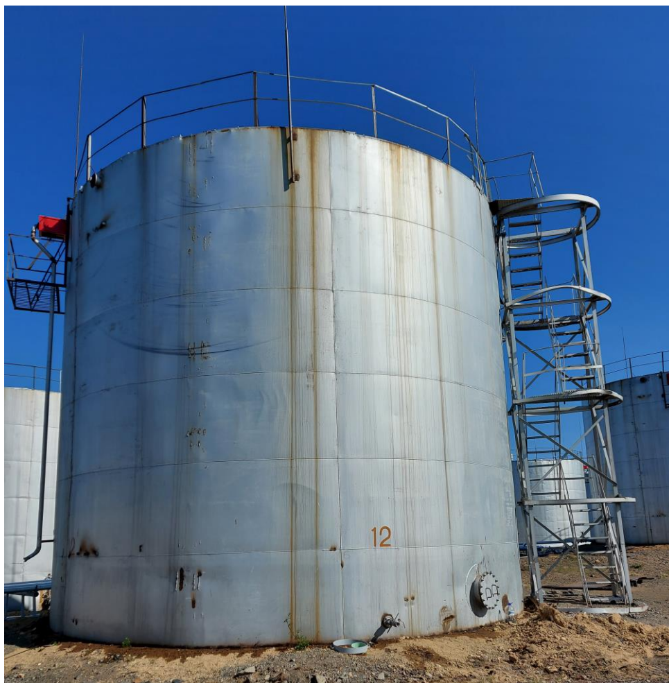
Рисунок 1 – Общий вид резервуара РВС-700 с заводским номером 12
