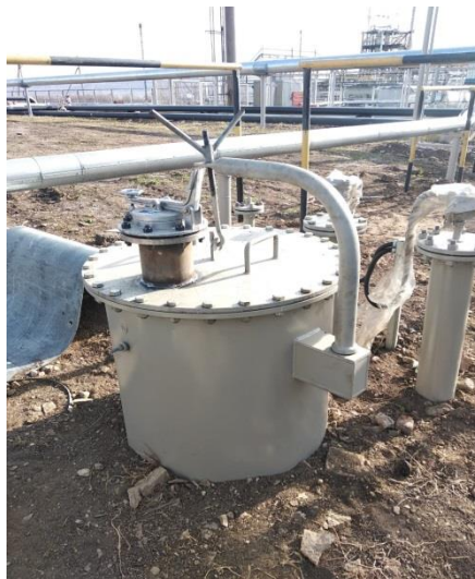
Рисунок 2 – Горловины и замерный люк резервуара стального горизонтального цилиндрического РГС-12,5
