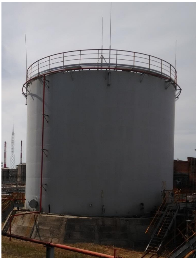
Рисунок 1 – Общий вид резервуара РВСП-2000 зав.№ 25
