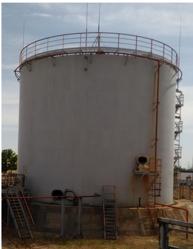
Рисунок 2 – Общий вид резервуара РВСП-2000 зав.№ 26
