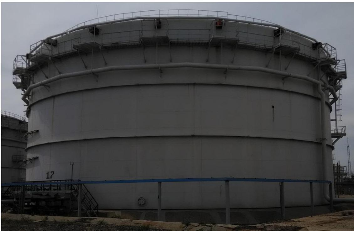
Рисунок 1 – Общий вид резервуара РВСП-20000 зав.№ 17
