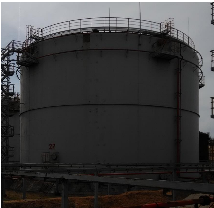
Рисунок 1 – Общий вид резервуара РВСП-10000 зав.№ 27
