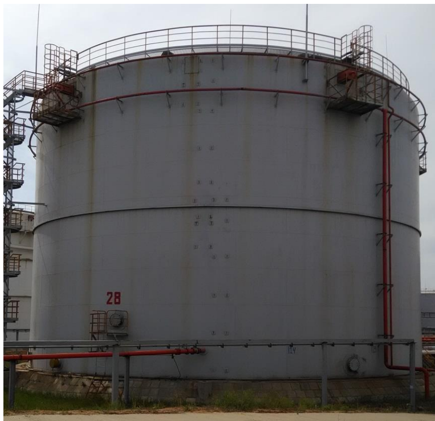
Рисунок 2 – Общий вид резервуара РВСП-10000 зав.№ 28
