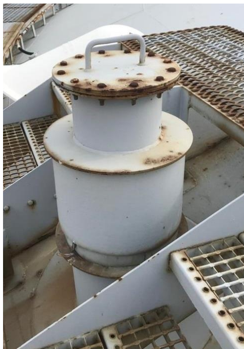
Рисунок 3 – Общий вид резервуаров РВСП-10000
