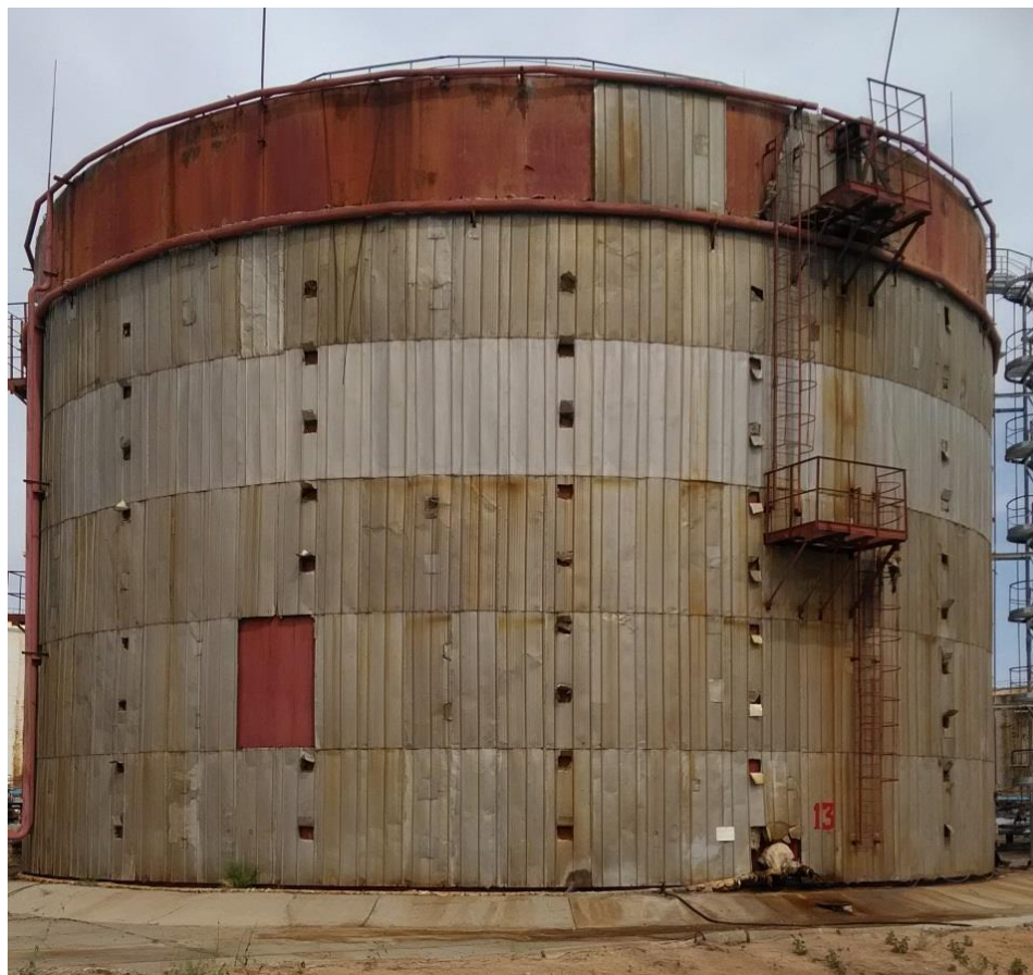
Рисунок 5 – Общий вид резервуара РВС-10000 зав.№ 13
