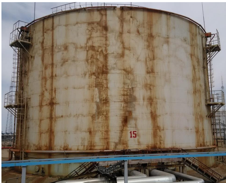
Рисунок 6 – Общий вид резервуара РВС-10000 зав.№ 15
