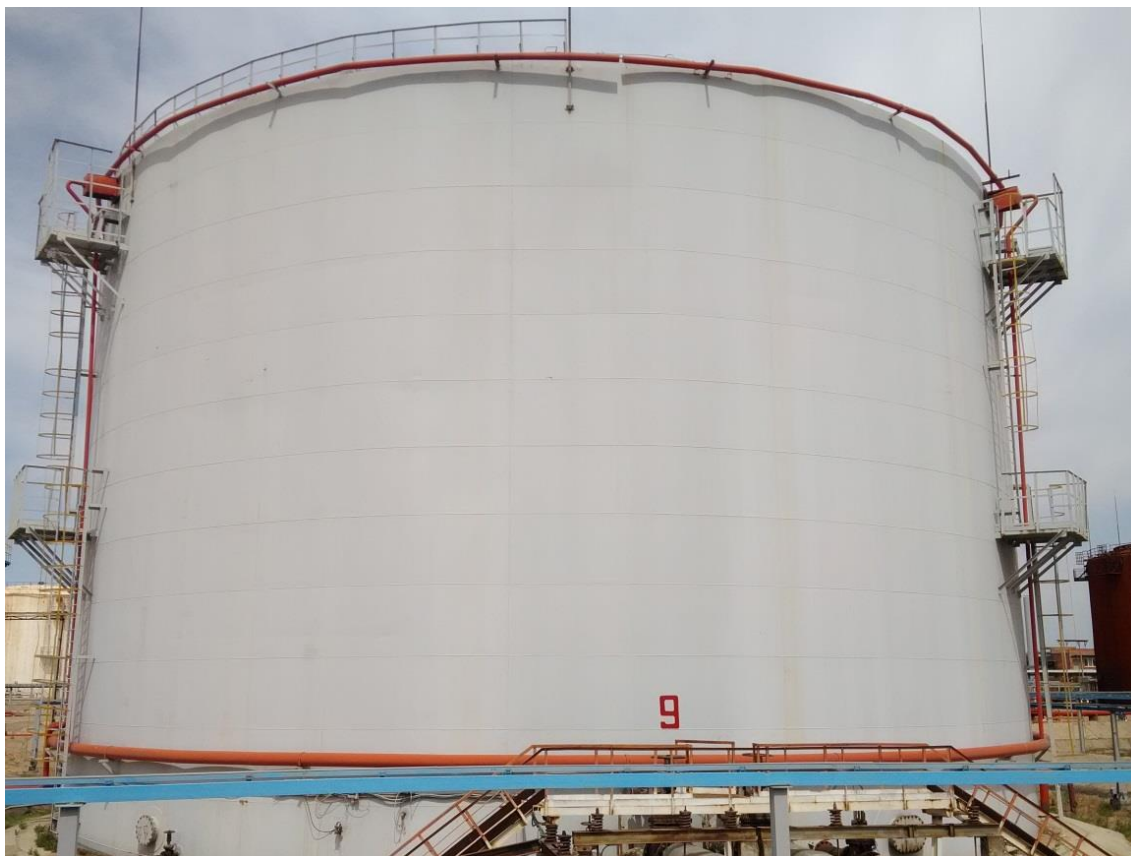
Рисунок 1 – Общий вид резервуара РВС-10000 зав.№ 9
