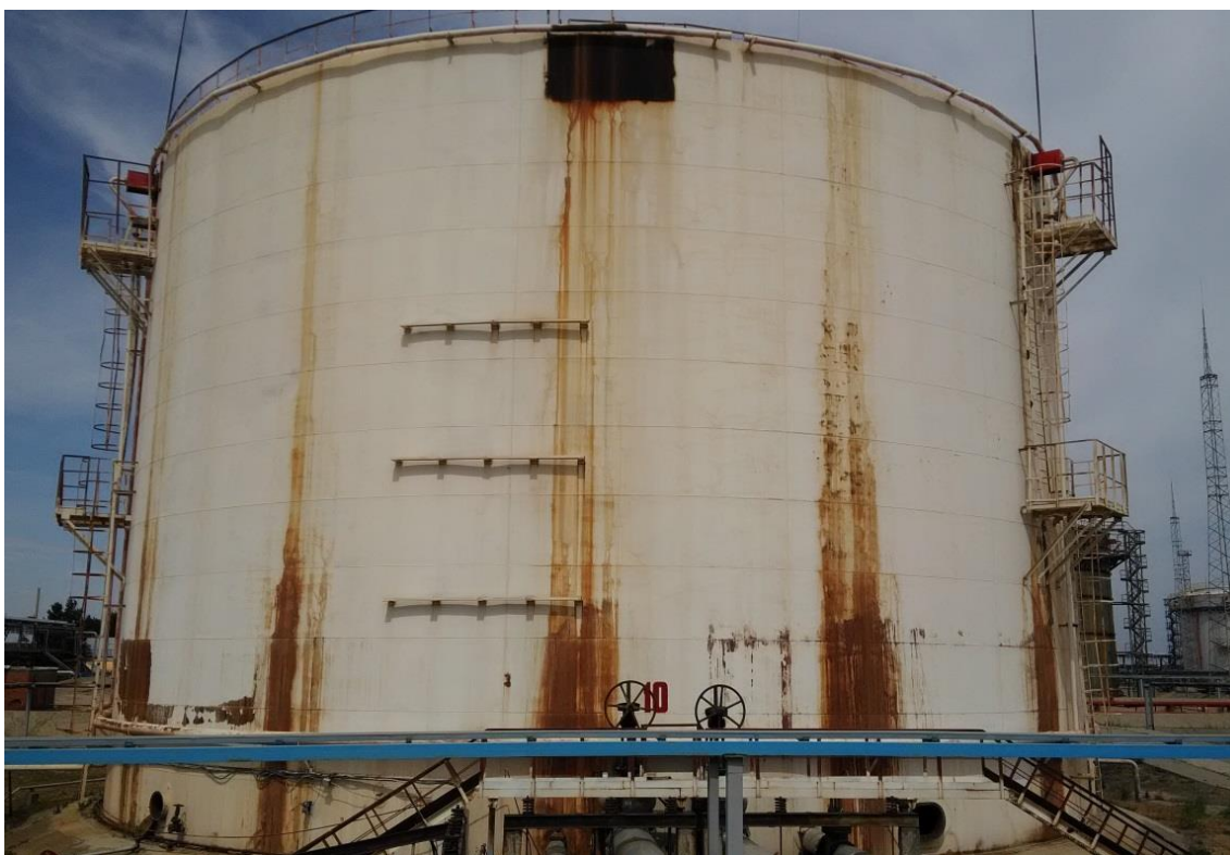
Рисунок 2 – Общий вид резервуара РВС-10000 зав.№ 10
