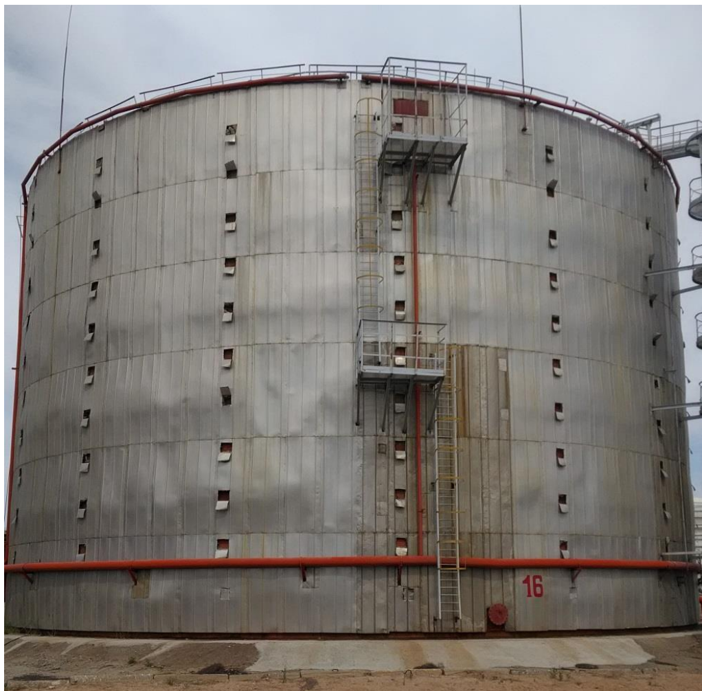
Рисунок 7 – Общий вид резервуара РВС-10000 зав.№ 16
