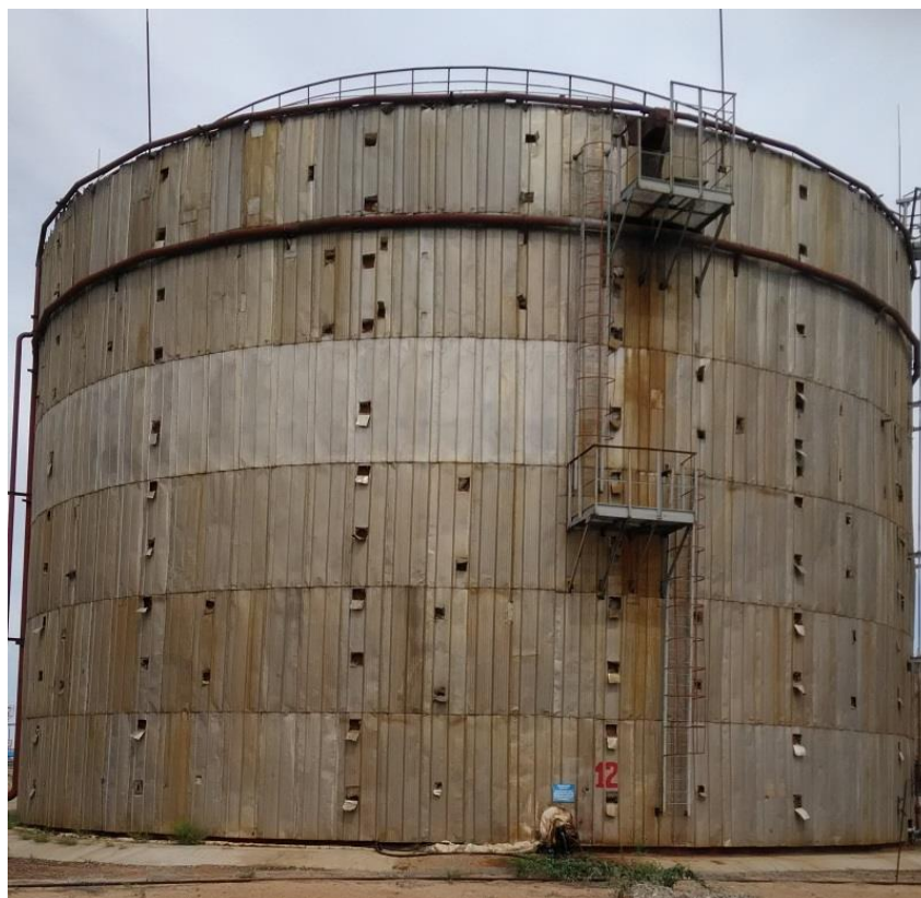
Рисунок 4 – Общий вид резервуара РВС-10000 зав.№ 12
