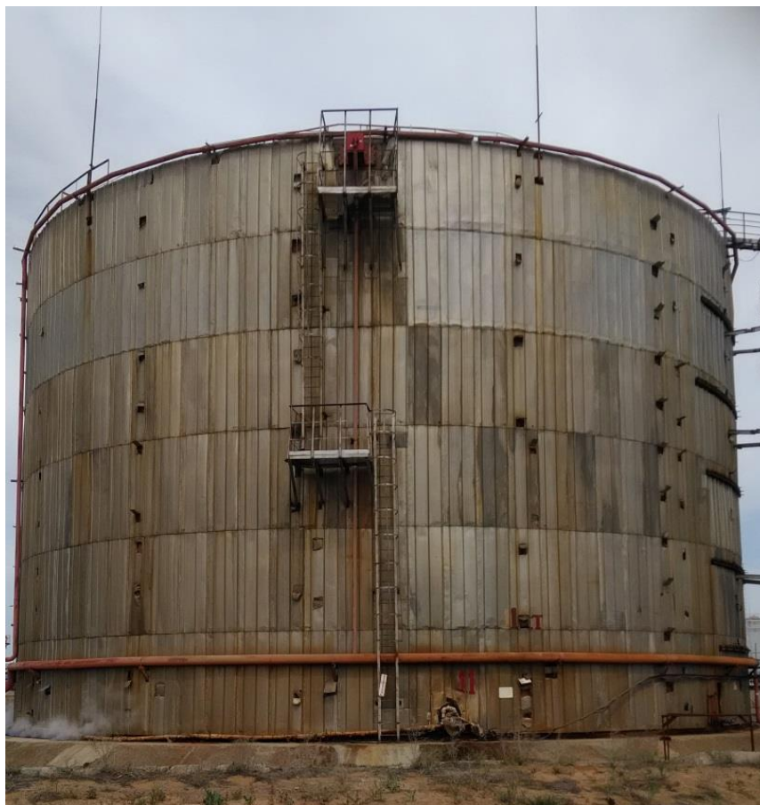
Рисунок 3 – Общий вид резервуара РВС-10000 зав.№ 11
