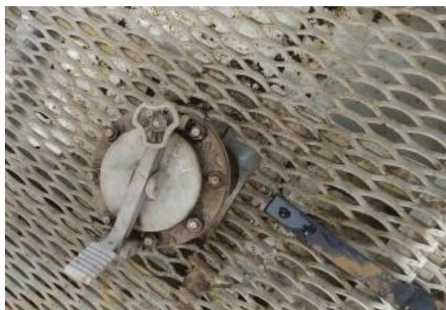
Рисунок 3 – замерной люк PVC-2000
