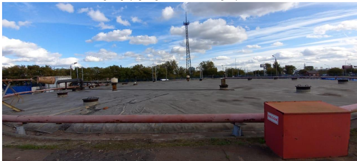
Рисунок 1 – Общий вид резервуара ЖБР-11500
