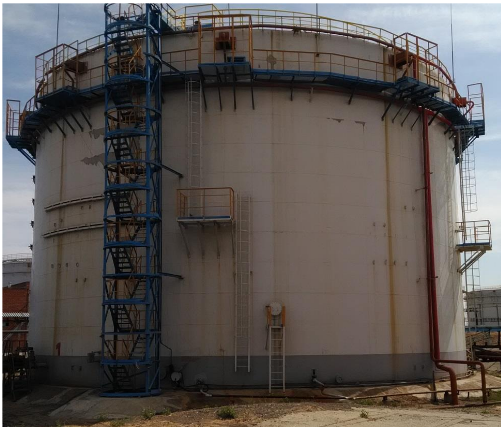
Рисунок 1 – Общий вид резервуара РВСП-10000 зав.№ 1
