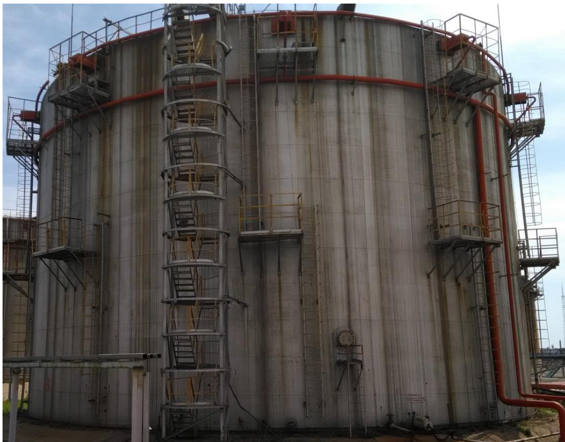
Рисунок 3 – Общий вид резервуара РВСП-10000 зав.№ 3
