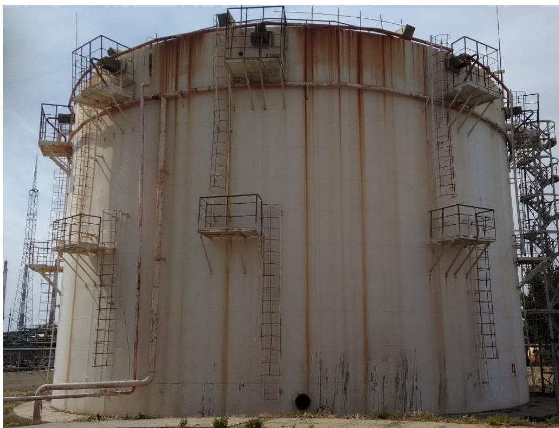
Рисунок 4 – Общий вид резервуара РВСП-10000 зав.№ 4
