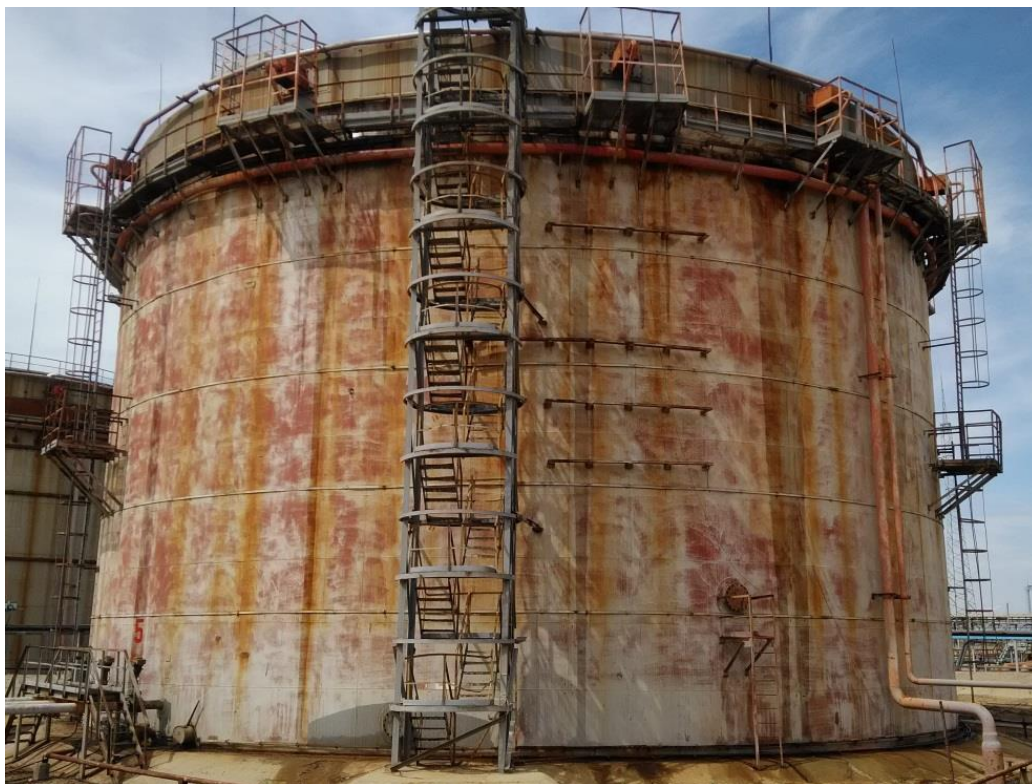
Рисунок 5 – Общий вид резервуара РВСП-10000 зав.№ 5
