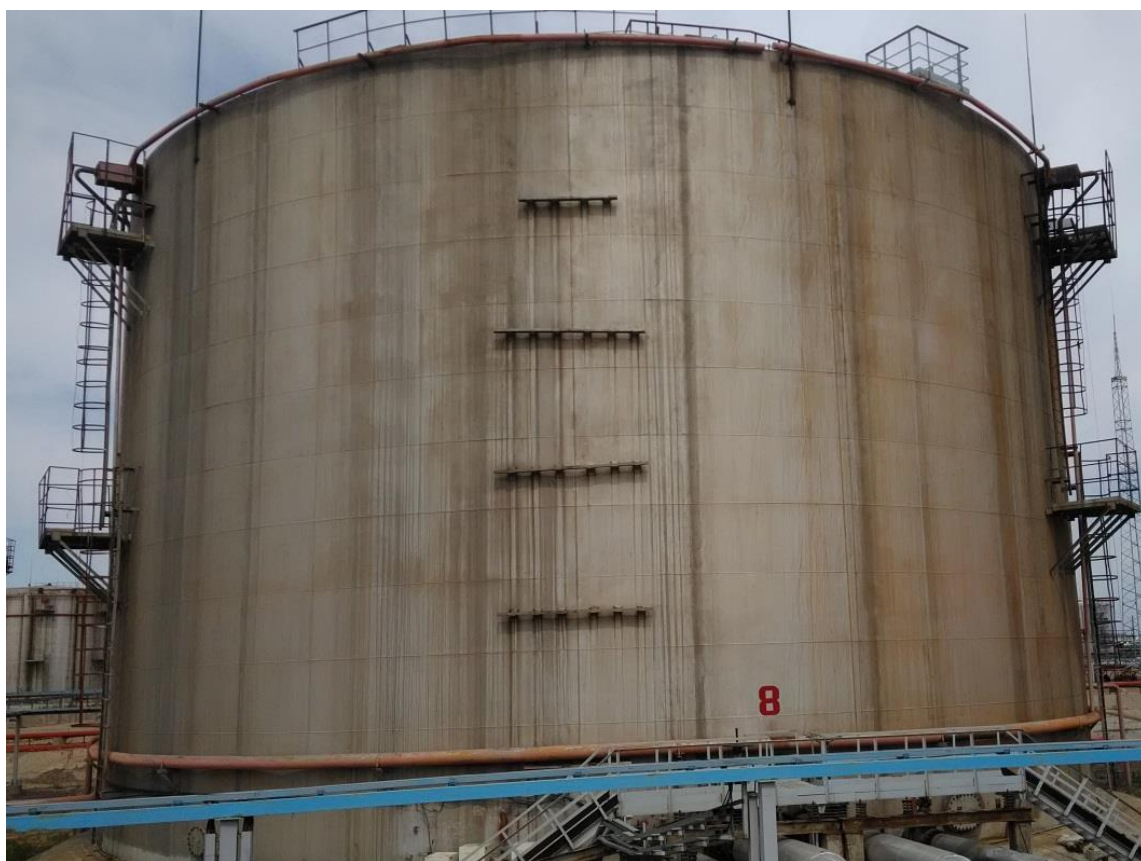
Рисунок 8 – Общий вид резервуара РВСП-10000 зав.№ 8
