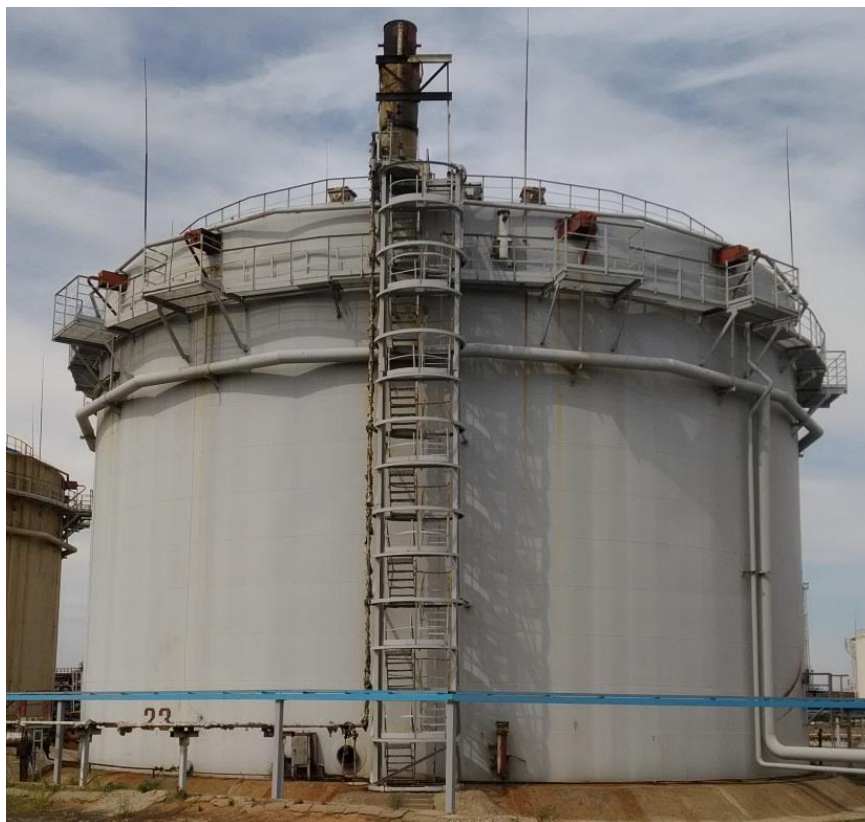
Рисунок 11 – Общий вид резервуара РВСП-10000 зав.№ 23
