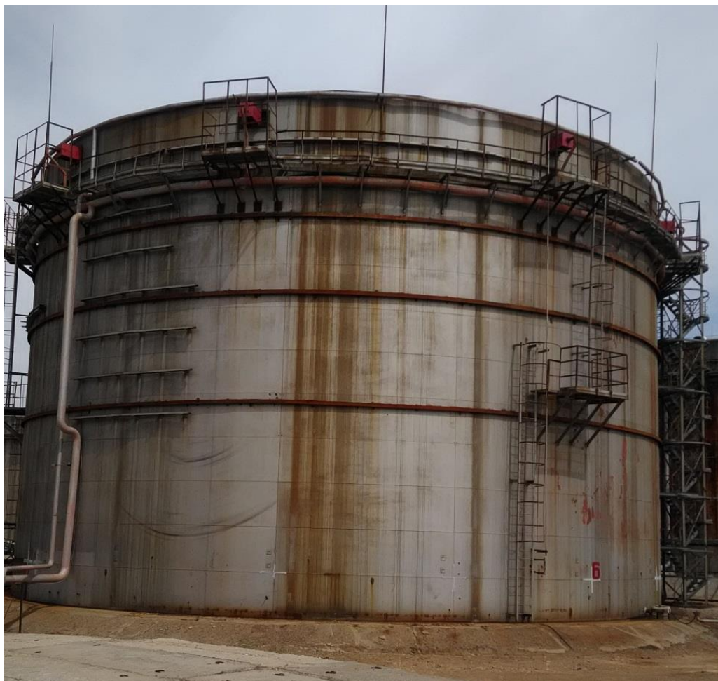
Рисунок 6 – Общий вид резервуара РВСП-10000 зав.№ 6
