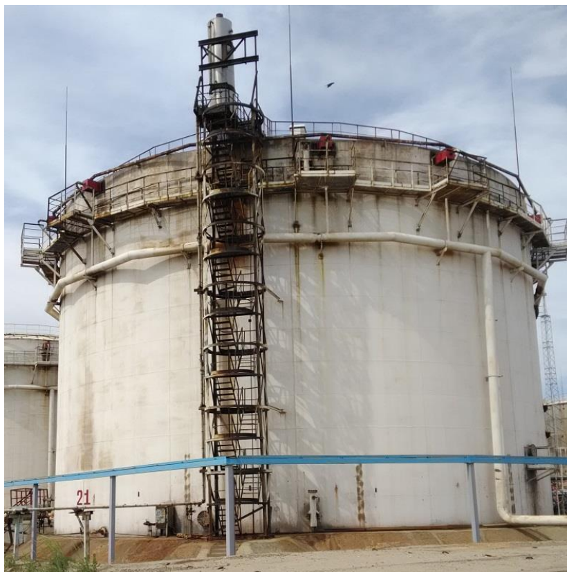
Рисунок 9 – Общий вид резервуара РВСП-10000 зав.№ 21
