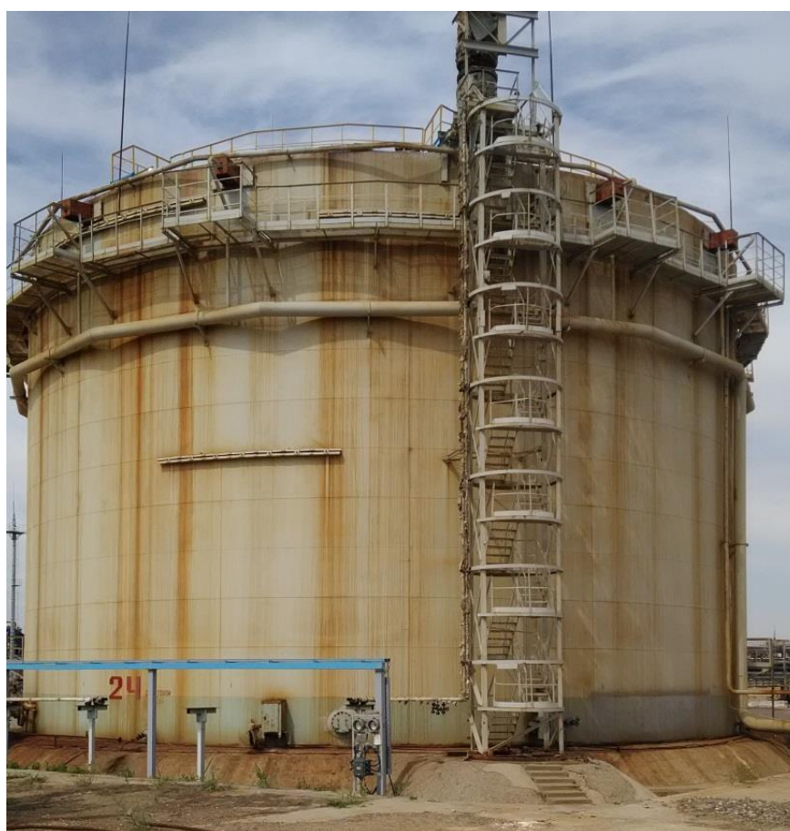
Рисунок 12 – Общий вид резервуара РВСП-10000 зав.№ 24
