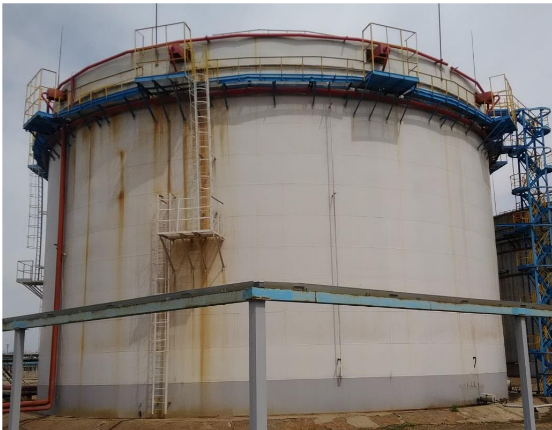
Рисунок 7 – Общий вид резервуара РВСП-10000 зав.№ 7
