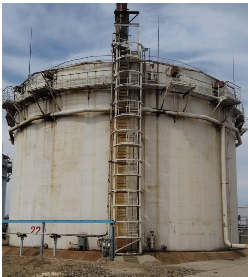
Рисунок 10 – Общий вид резервуара РВСП-10000 зав.№ 22
