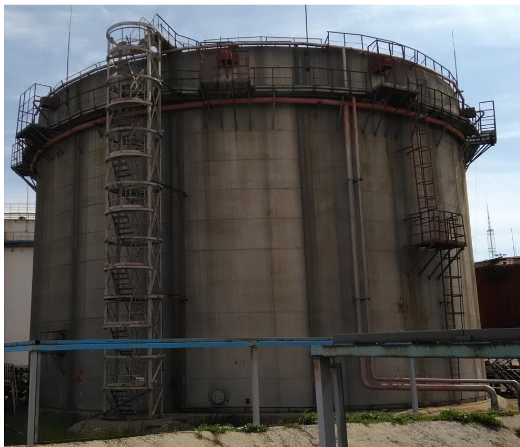
Рисунок 2 – Общий вид резервуара РВСП-10000 зав.№ 2
