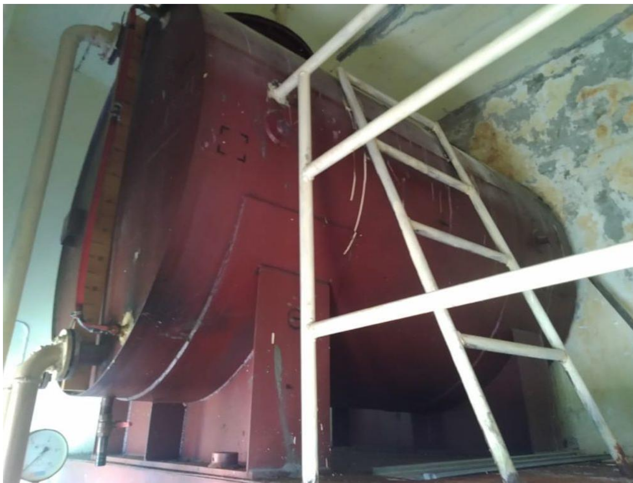
Рисунок 2 – Общий вид резервуара Р-3
