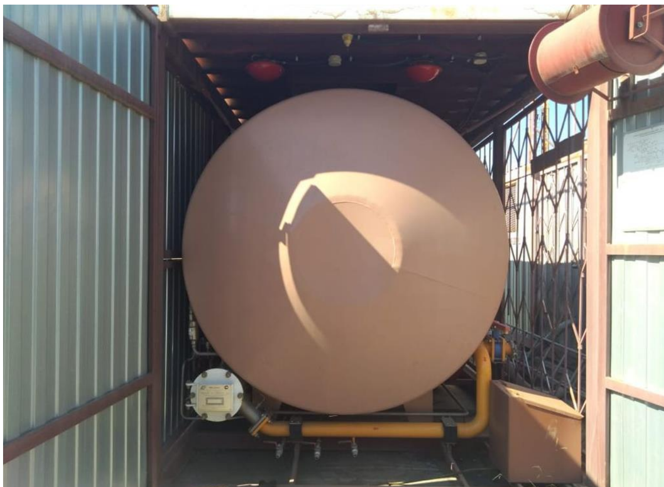
Рисунок 2 – Общий вид резервуара Рк-8
