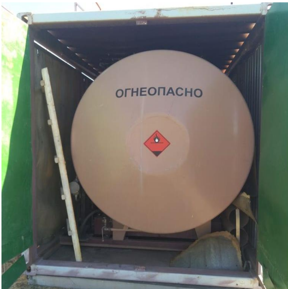
Рисунок 2 – Общий вид резервуара Рк-17
