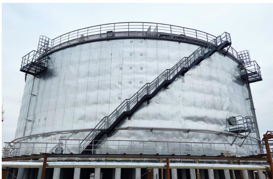
Рисунок 1 – Общий вид резервуаров
