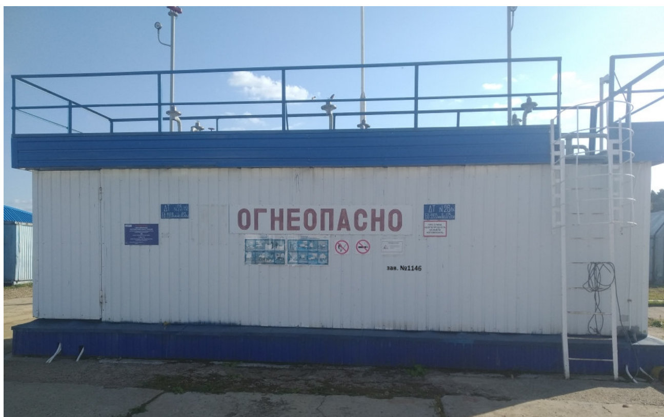
Рисунок 2 – Общий вид резервуара РГС-20 ЦТТиСТ, участок Улу-Теляк
