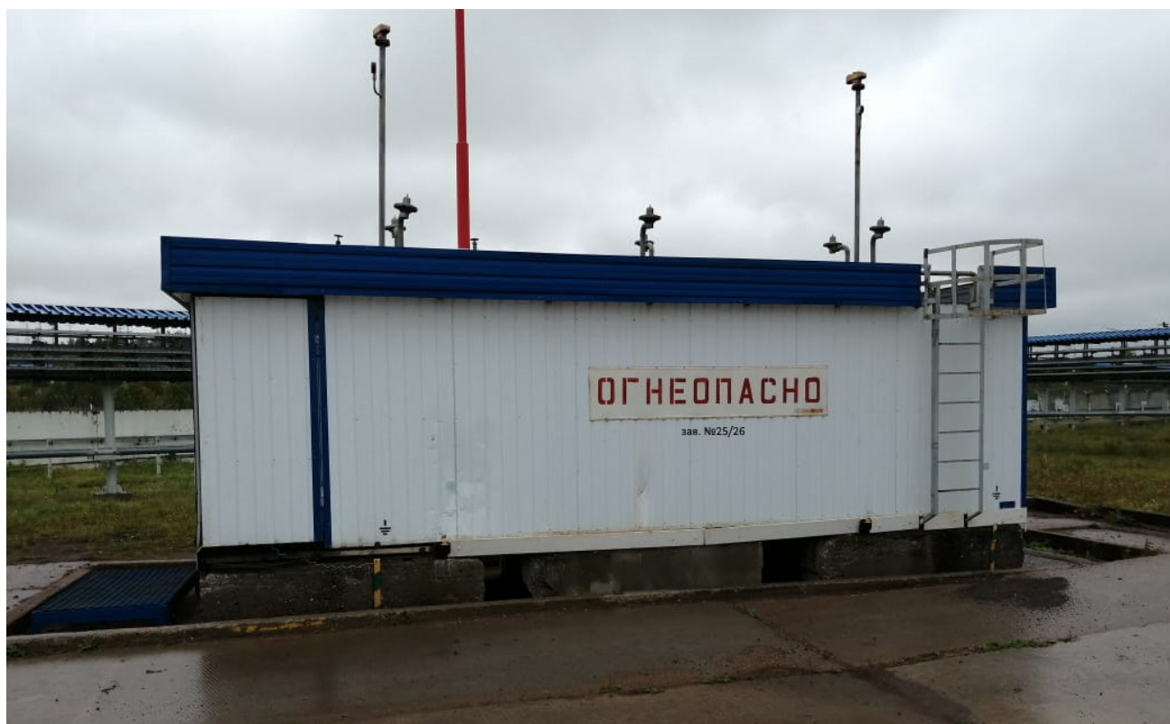
Рисунок 1 – Общий вид резервуара РГС-20 ЦТТиСТ, участок Кропачево
