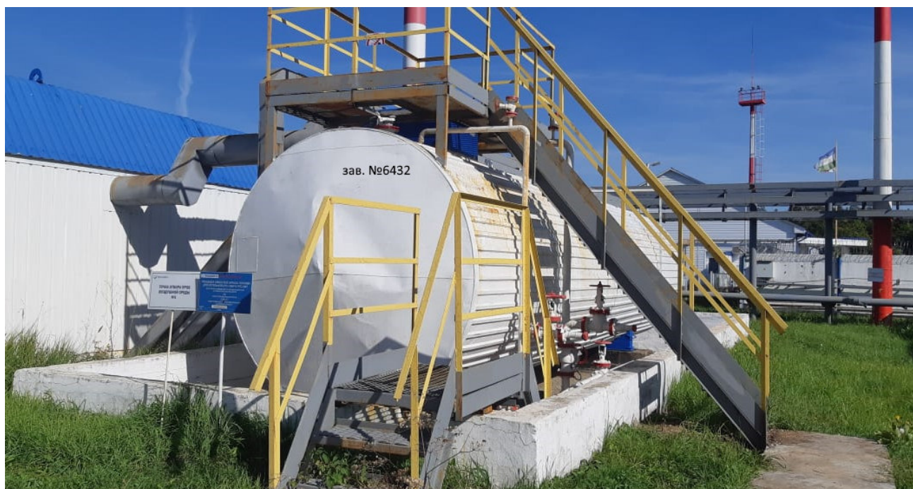
Рисунок 1 – Общий вид резервуара РГС-50
