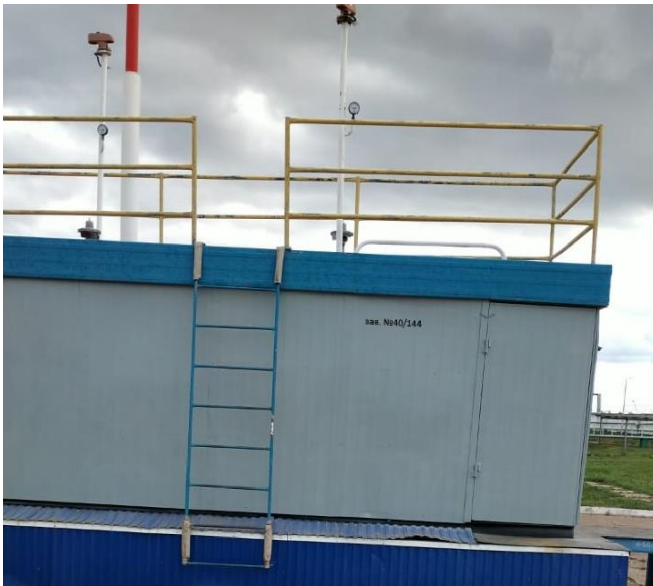
Рисунок 1 – Общий вид резервуара РГС-20
