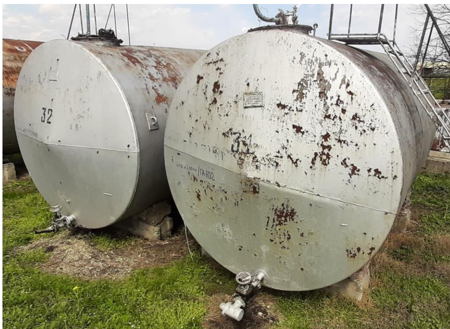
Рисунок 1 – Общий вид резервуаров РГС-25
