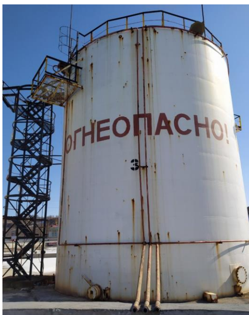
Рисунок 1 – Общий вид резервуара РВСП-1000
