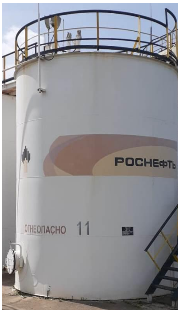
Рисунок 1 – Общий вид резервуаров РВС-100
