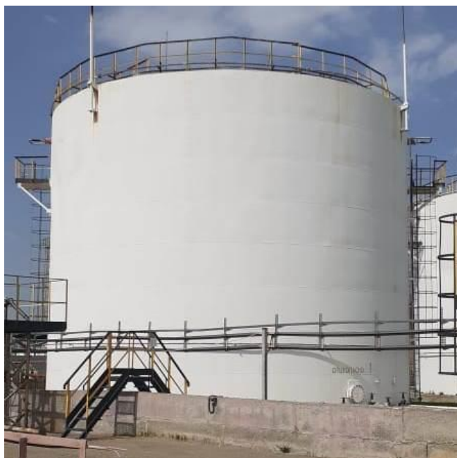
Рисунок 4 – Общий вид резервуаров РВС-2000
