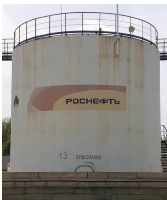
Рисунок 2 – Общий вид резервуаров РВС-700
