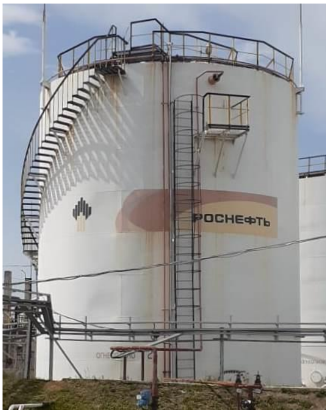
Рисунок 3 – Общий вид резервуаров РВС-1000
